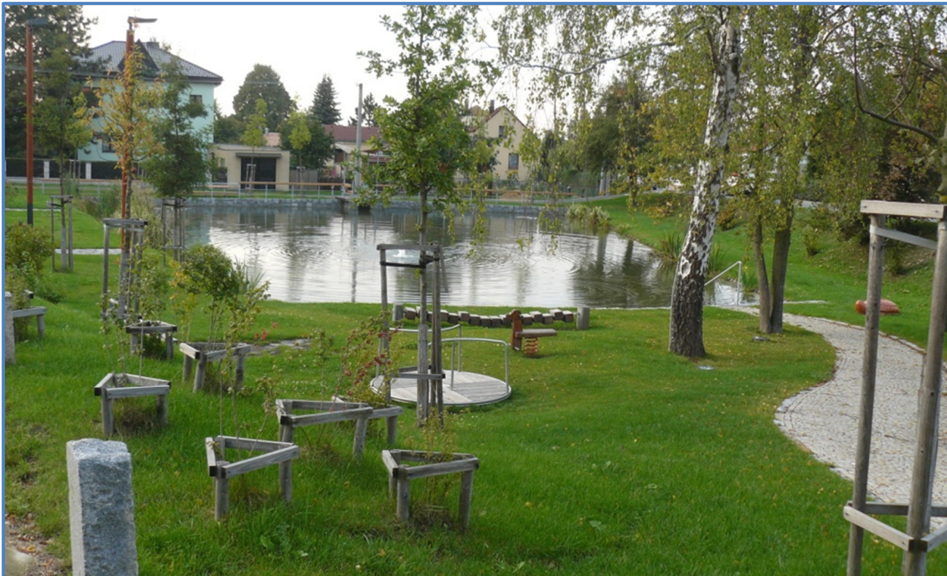
| Revitalizace návesního rybníka a okolí – Braškov; zdroj: web obce
