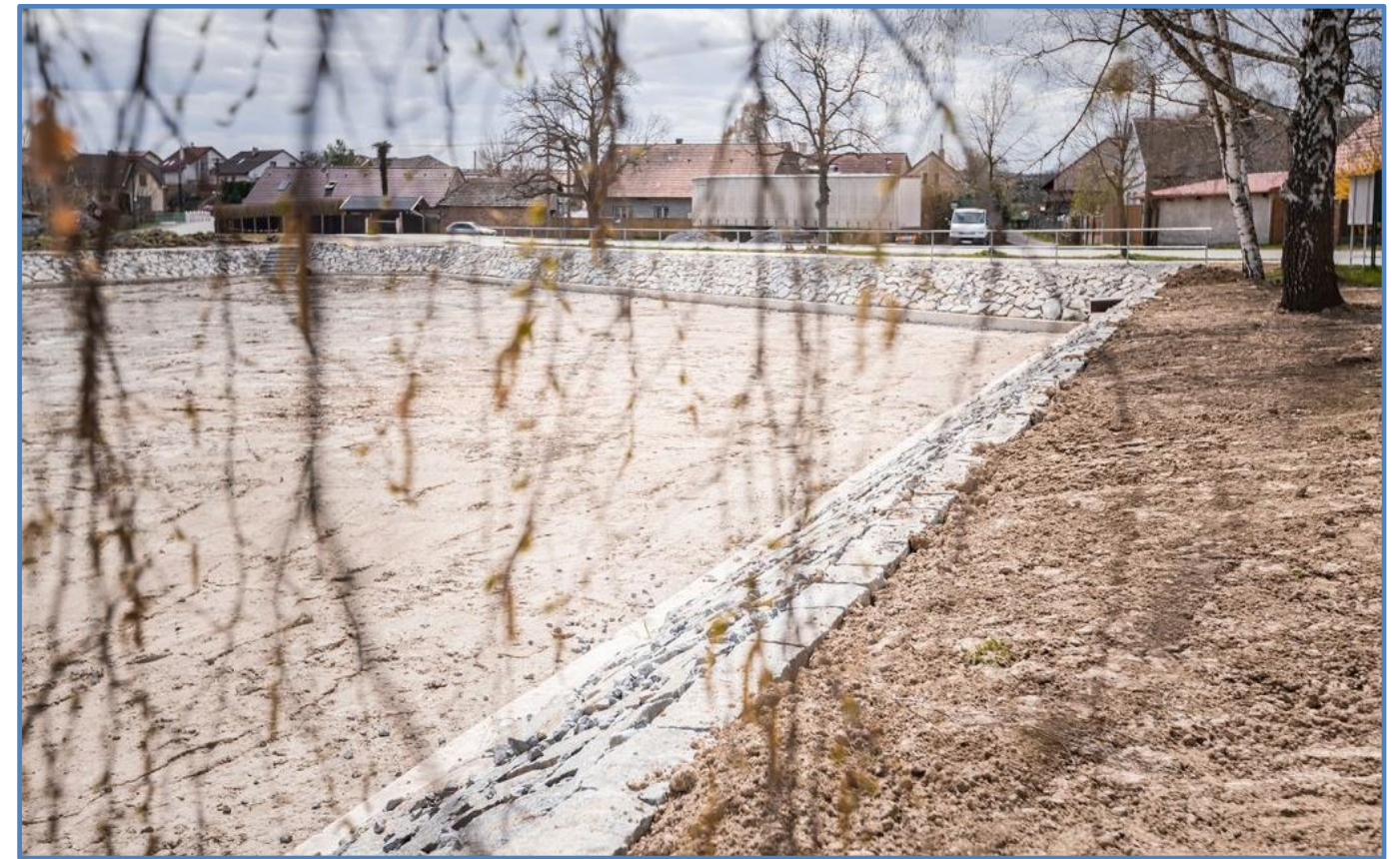
| Revitalizace nádrže - opevnění lomovým kamenem – Zaječice; zdroj: web Instav Hlinsko
